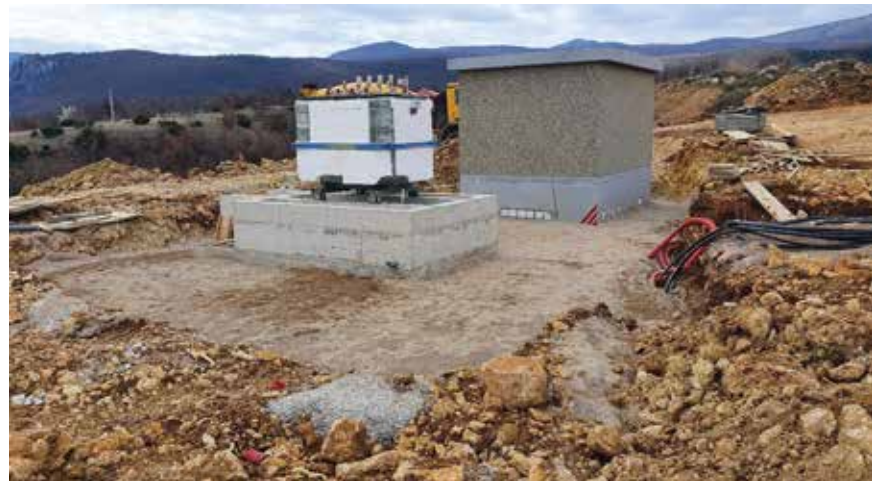
Radovi na internoj trafostanici
