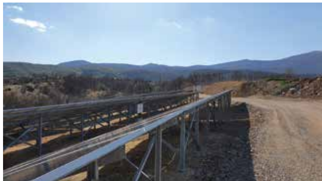
Postavljanje FN panela i izmjenjivača
