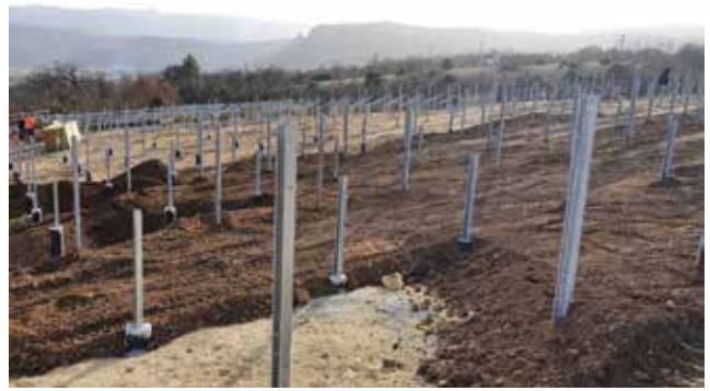
Temeljenje i montaža čelične konstrukcije – modificirano rješenje
