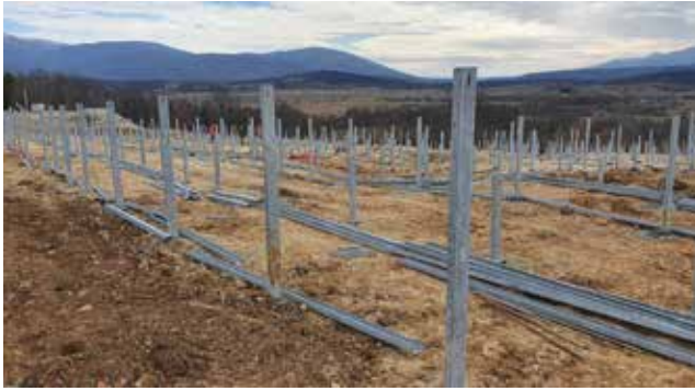
Temeljenje i montaža čelične konstrukcije
