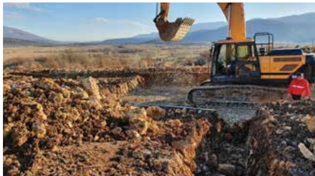
Zemljani radovi za kabelsku instalaciju i internu trafostanicu
