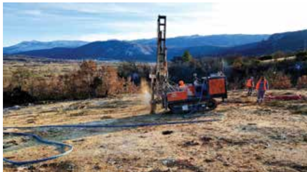
Bušenje za temeljenje čelične konstrukcije
